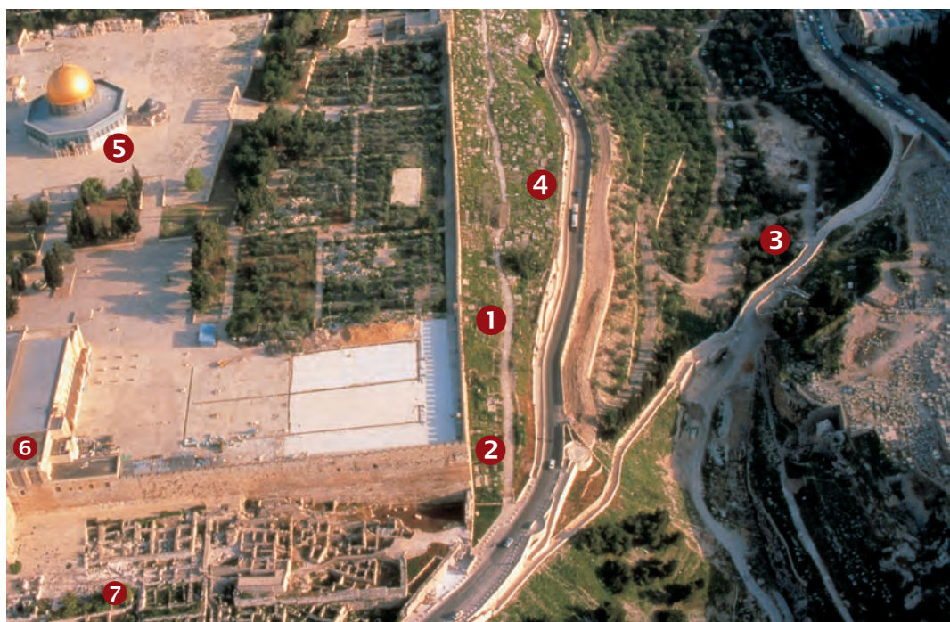
Abb. 21 Der Richtungs-Knick in der Ostmauer bezeichnet noch heute den Punkt, von wo ab die Makkabäer den Tempelplatz nach Süden (im Bild: unten) erweiterten. Die Distanz von der Südost-Ecke bis zum Knick beträgt ca. 73 m. 90
