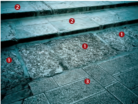
Abb. 53 Die unterste Stufe der nord-westlichen Treppe zur Moslem-Plattform. Sie besteht aus mächtigen Aschlar-Blöcken.
