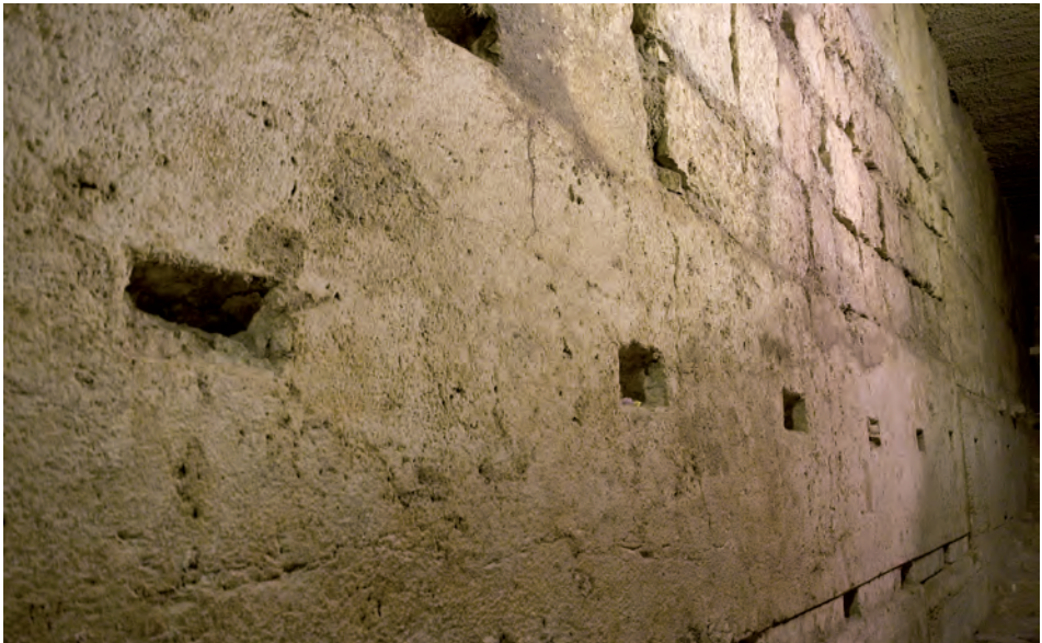
Abb. 12 Blick in den Westmauer-Tunnel. Im Bereich der Bildmitte: Teilansicht des größten bisher gefundenen Bausteines, der zum Zweiten Tempel gehörte. Er wiegt ca. 578 t. Seine Länge beträgt 13,7 m, seine Höhe 3,5 m und seine Breite ca. 4,5 m. 52 Solche mächtigen Steine in den Fundamentbereichen der Mauern lieferten besondere Festigkeit im Fall von Erdbeben.
