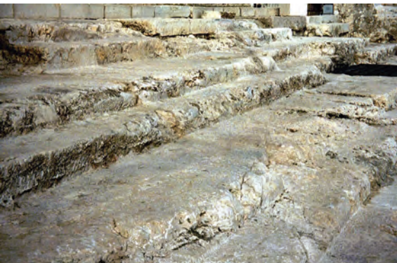
Abb. 34 Die Stufen vor der Schönen Pforte wurden zu einem großen Teil direkt aus dem Grundgestein herausgeschlagen.
