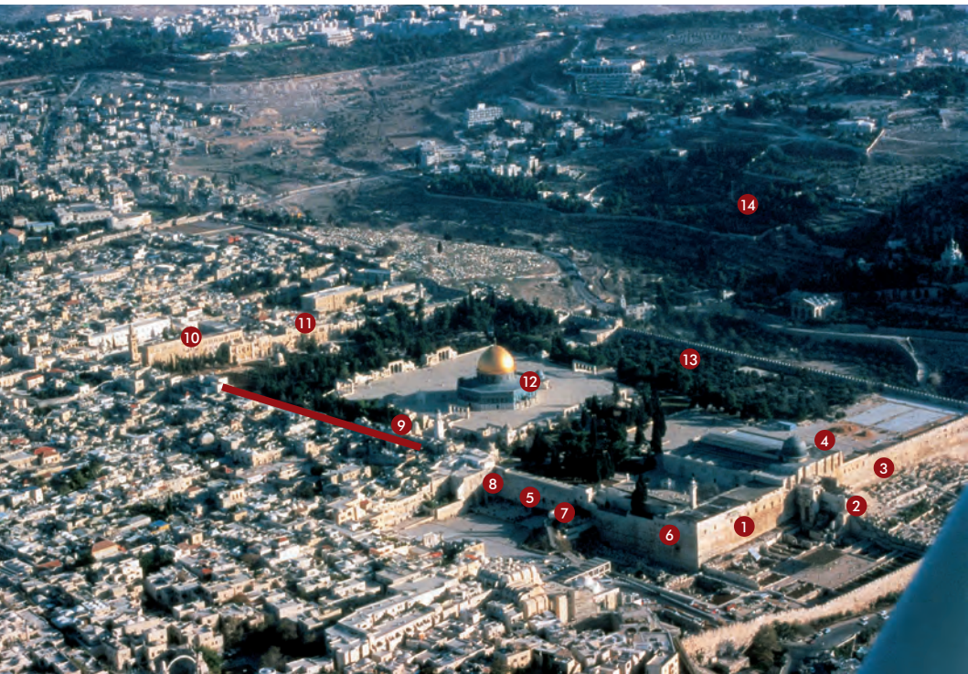
Abb. 30 Luftbild von Südwesten her fotografiert, mit Blick auf den Tempelplatz von heute. Rote Linie: Verlauf des Westmauer-Tunnels entlang der einstigen Tempelmauer
