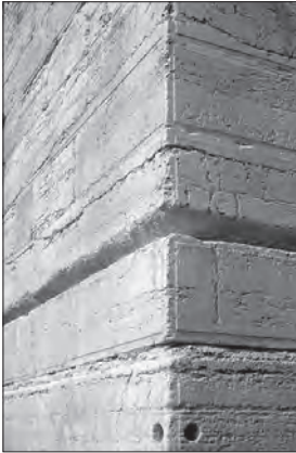
An der Südwest-Ecke der Tempel-Umfassungsmauer.
